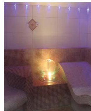
Soleeindüsung Dampfkabine, KWS
